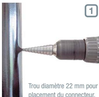
Trou diamètre 22 mm pour placement du connecteur.
